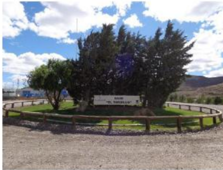
Batería El Tordillo – Ingreso a Yacimiento
