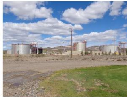
Planta de Tratamiento de Crudo
