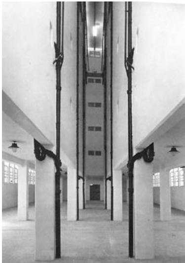
Figura 6. Vista de talleres y pozo central de ventilación de la cárcel de Olmos (1939). Álbum Banco Crédito Provincial. Archivo Penitenciario de la provincia de Buenos Aires
