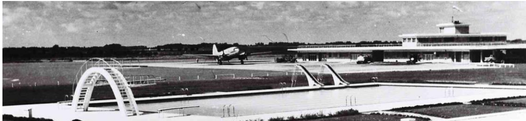
Figura 6: Vista de instalaciones anexas. Fuente: Archivo General de la Nación
