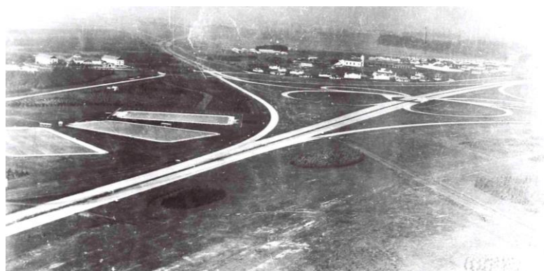
Figura 5: Vista aérea del entorno del aeropuerto con las obras encaradas en la zona. Fuente: Archivo general de la Nación
