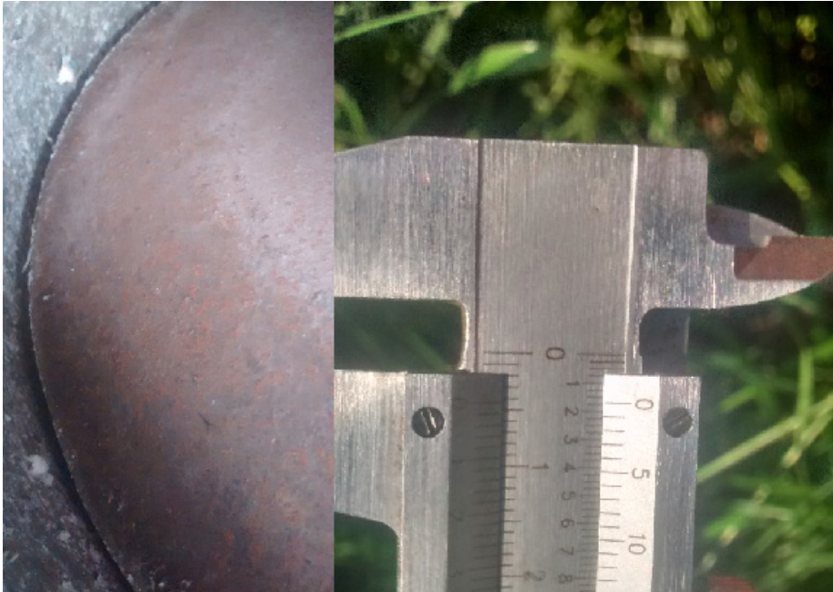
Imagen N° 9: Vista de la luz pared-sinfín del tubo de descarga de la monotolva y medición con calibre.
