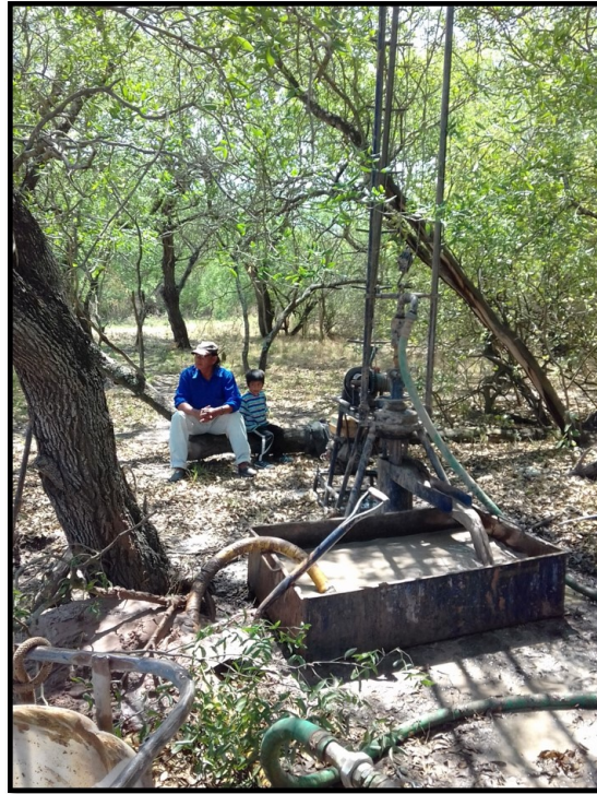
Figura 6.16: Proceso de construcción de la base para la colocación de las bombas manuales.
