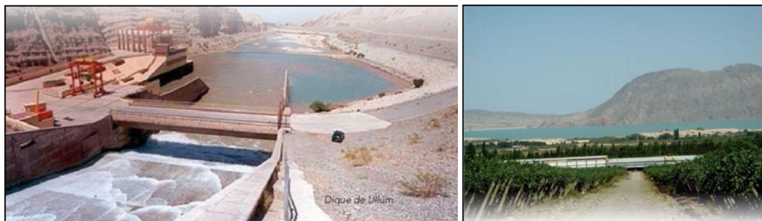
Construcción de embalses
