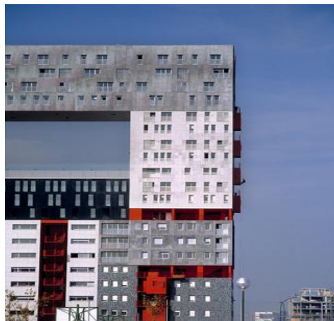
Edificio Mirador. MVRDV. Madrid.2004
