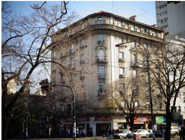
Figura 2. Fotografía del edificio desde la esquina (año 2014)
