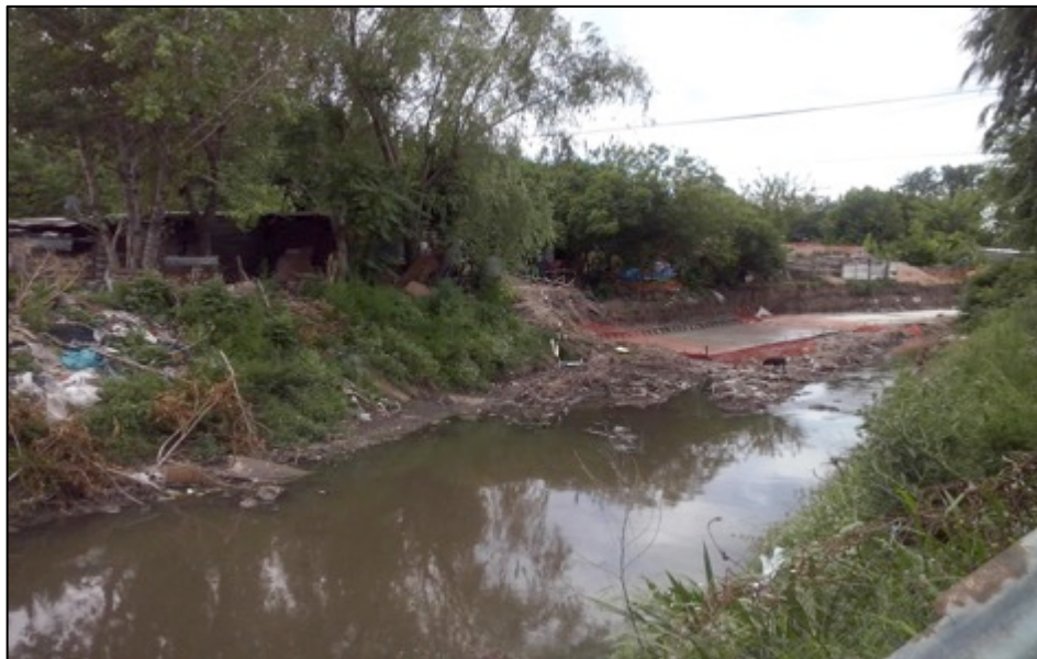
Fotografía propia tomada desde el patio de la casa de Claudia. Puede observarse la base del canal en construcción del lado de enfrente del arroyo, a algunos metros del barrio.
