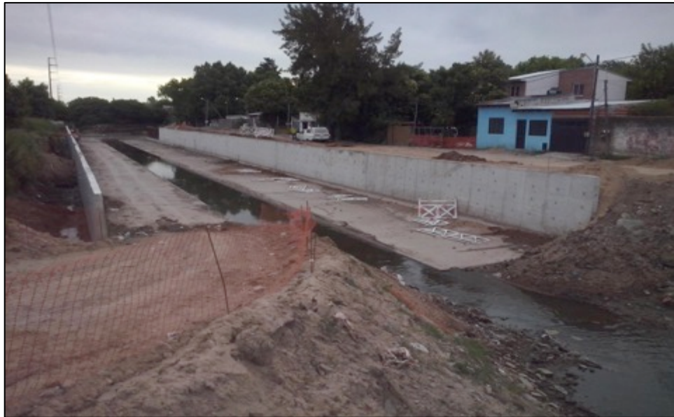
Fotografía propia tomada desde el inicio del tramo once de la obra, sobre el puente de la Avenida 137 en dirección hacia el barrio. En ella pueden observarse la base del canal y los muros de contención de hormigón y el pequeño caudal de agua que corre en el centro.
