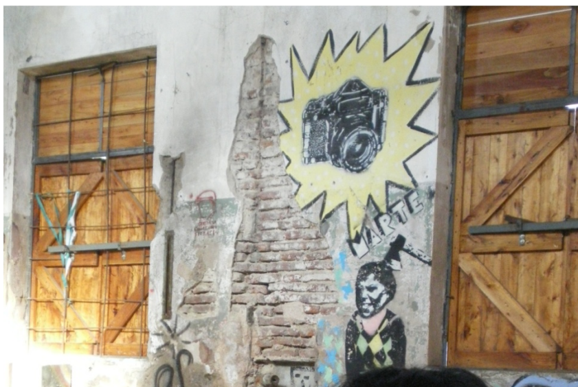
Imagen 2 y 3: Paredes internas del Centro Cultural.
