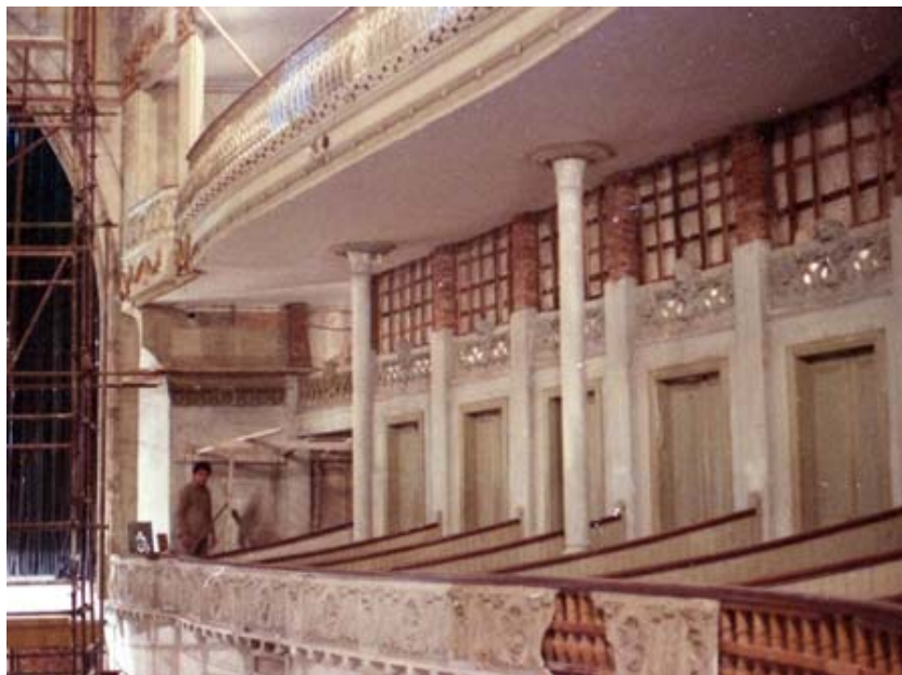
Figura 7. Construcción de los tabiques de cierre entre la sala y las circulaciones (fotografía tomada en 1986).
