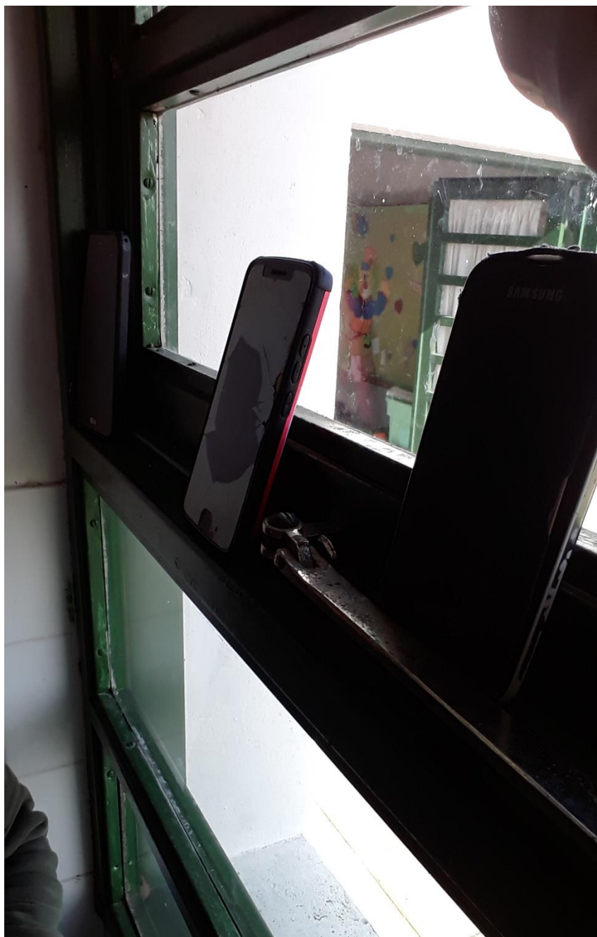
Foto 1. Teléfonos en el ventiluz de la cocina de la escuela primaria nº16.
