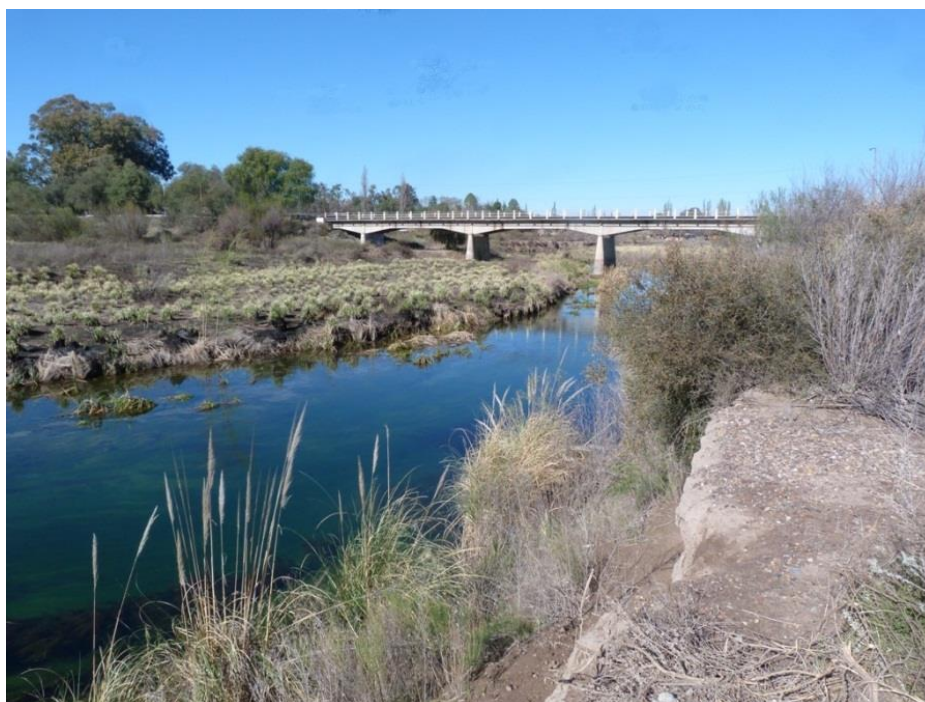
Figura 6.12. Cuenca inferior del río Atuel en el área del sitio La Guevarina. Al fondo, puente de la RN 143.
