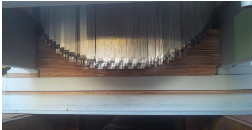
Fig. 1. Porción de aislamiento del núcleo
