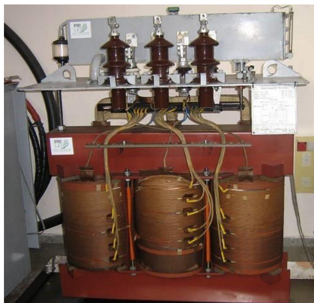
Figura 2.9 - Bobinado de un transformador trifásico.
