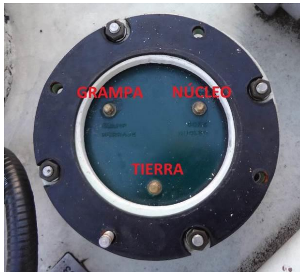
Figura 3.14 - Conexión a tierra de núcleo y grampa removida.
