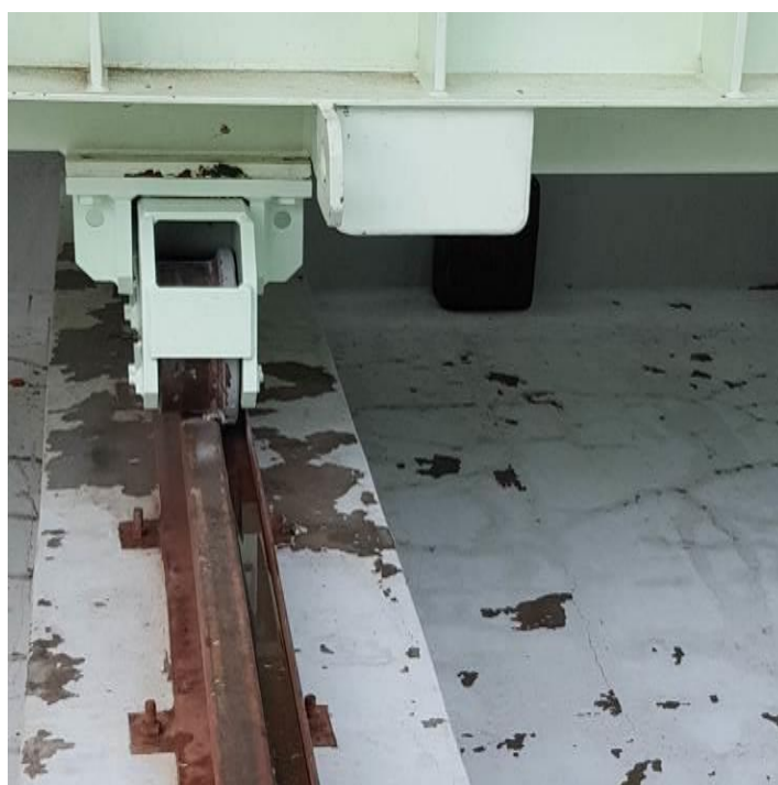
Figura 2.25 - Rueda del transformador sobre el riel.
