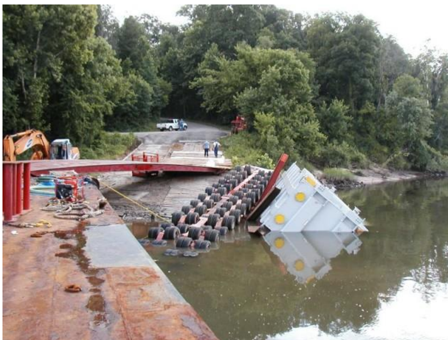
Figura 2.23 - Negligencia en manejo de transformador. Fuente: www.cargolaw.com
