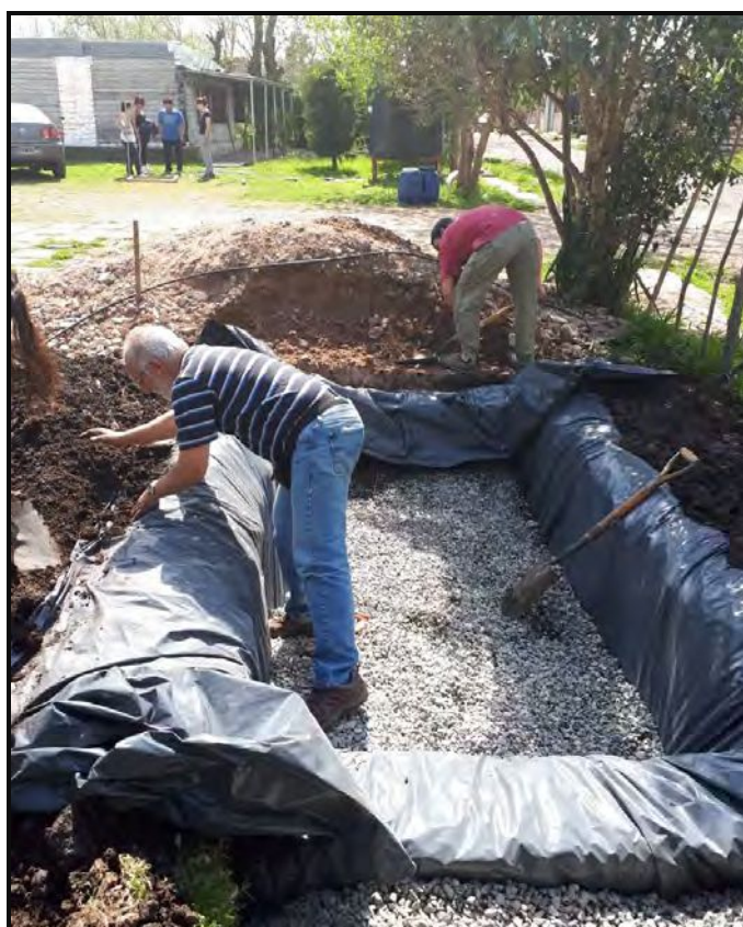
Figura 4.- Construcción del recinto de tratamiento (humedal)
