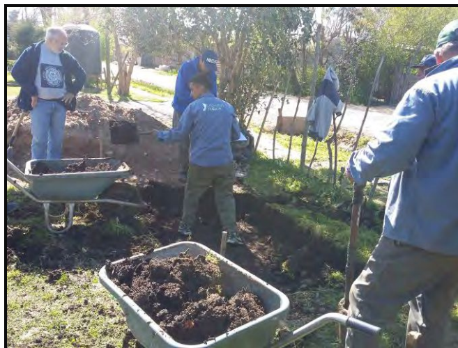
Figura 3.- Excavación del humedal por parte de los cooperativistas
