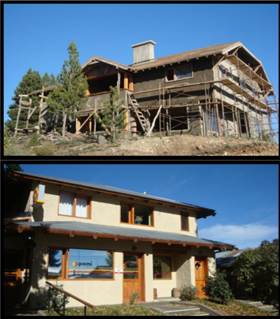
Figura 15 Viviendas hechas en San Carlos de Bariloche siguiendo el sistema constructivo de ballon-frame con uso de madera proveniente de raleos comerciales de pino ponderosa y otras especies de la región. Una vez realizado en revoque, la madera queda escondida, no visible a la vista, simulando una casa de mampostería.
