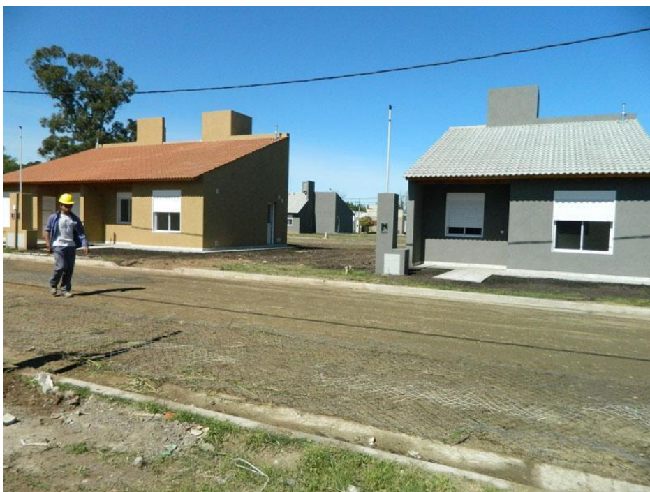
Figura 11: viviendas en construcción del barrio Falucho LIII, año 2015.
