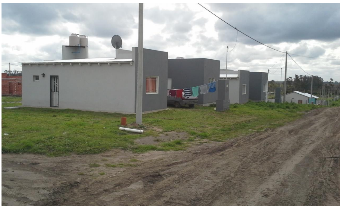
Figura 15: Viviendas finalizadas de una de las asociaciones civiles a las cuales se le otorgaron terrenos a partir de lo estipulado en la Ordenanza Municipal N°13.579, en el Barrio la Movediza.
