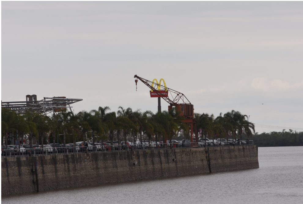
Fotografía propia tomada en el Puerto de Santa Fe, en el área de servicios, donde es posible visualizar la convivencia de la vieja estructura portuaria con locales comerciales como el de la empresa transnacional McDonalds. Agosto de 2017.
