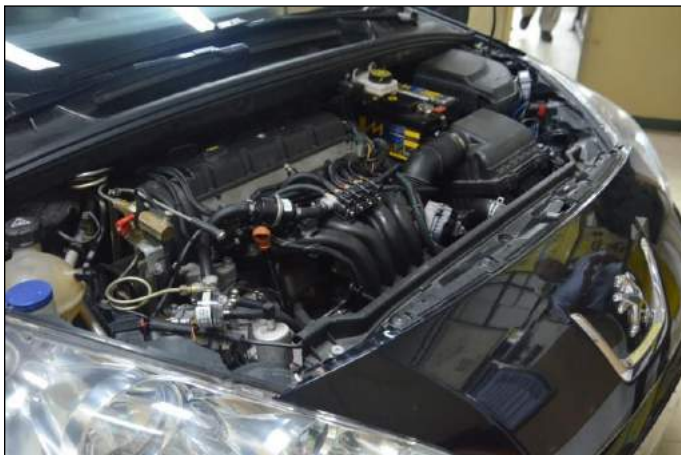
Figura 7. Vista del motor con el equipamiento de inyección de gas.
