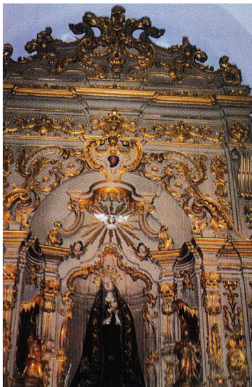
Retablo en estado previo a restauración
