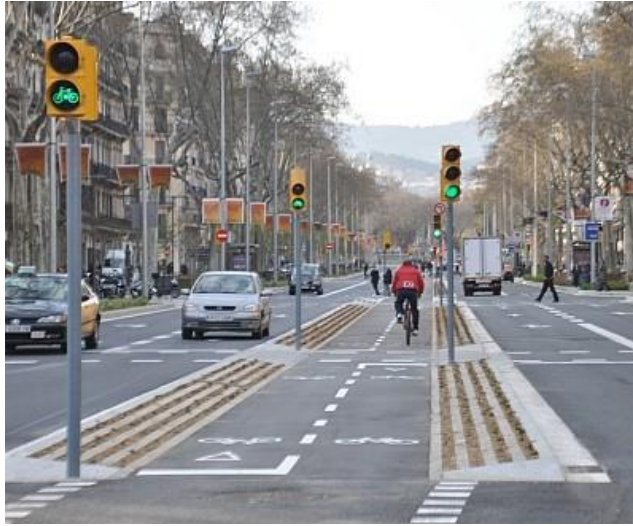
Foto 5. Bicisendas en Montreal Barcelona, integradas a la infraestructura vial antes, muy bien señalizadas y con indicaciones lumínicas propias
