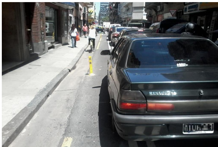
Foto 12. Bisisenda angosta, sin protección lateral que divida tipos de modos de transporte, e incluso con demarcación dispuesta en el medio de la vía.
