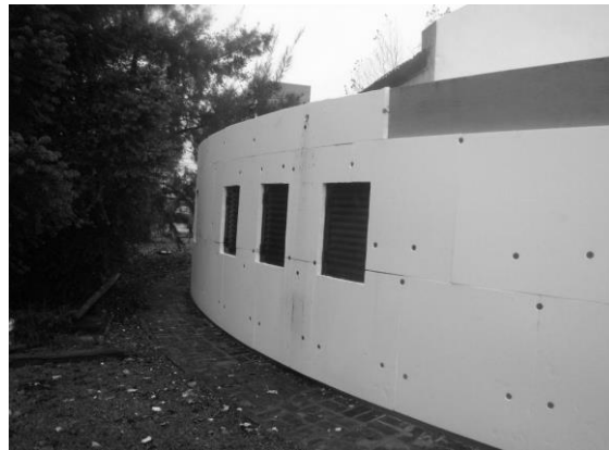
Figura 5 - Colocación de EPS en la cara este
