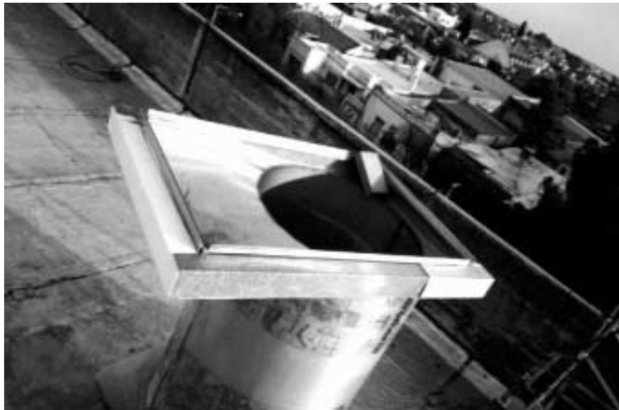
Figura 1: Foto del destilador solar asistido durante la etapa de montaje de las aislaciones de la batea.
