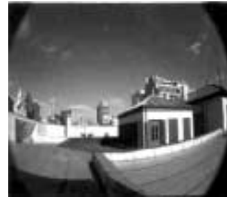
Cubierta del edificio, volumen de la linterna, lado Noroeste
