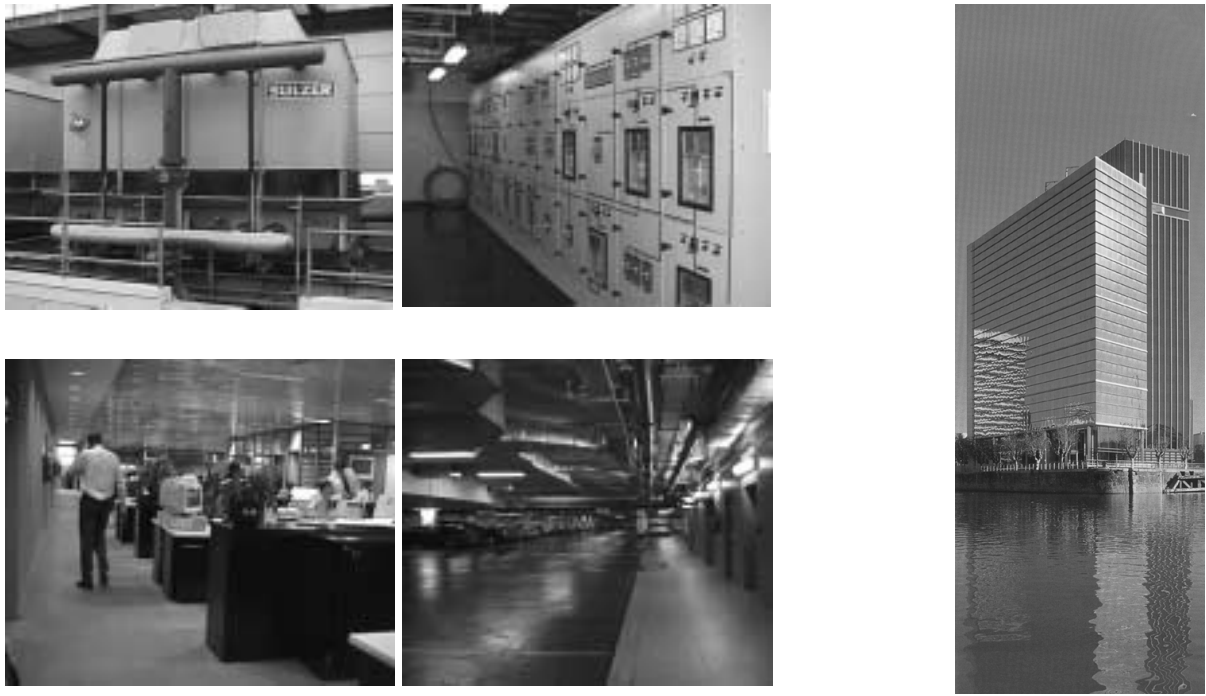
Fig.3. Fotografías del interior del edificio Telecom y de la fachada Sur (Hampton y Rivoira, 1998g).
