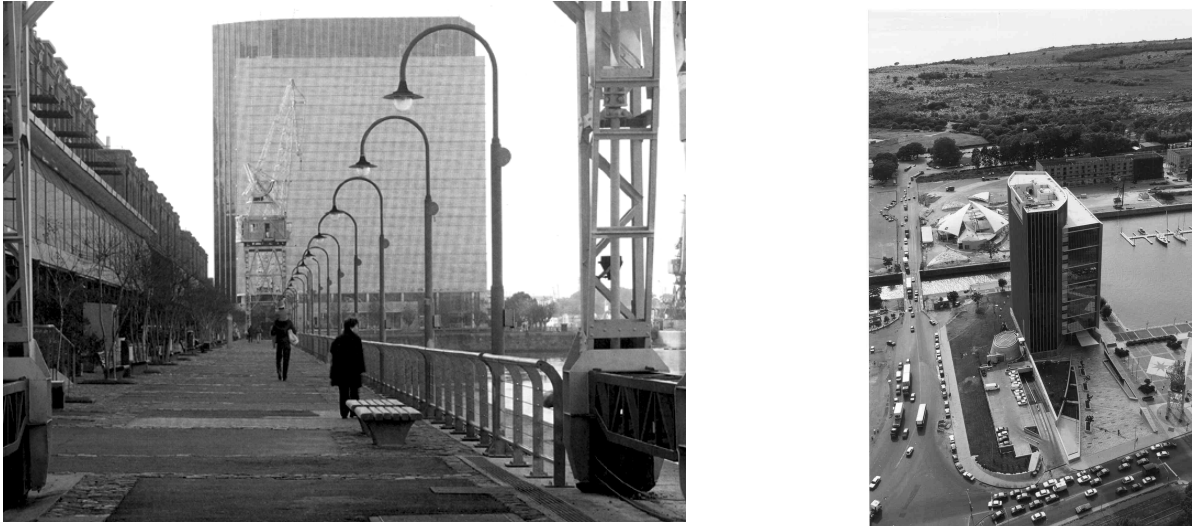
Fig.1. Fotografías del edificio Telecom fachada Sur (Hampton y Rivoira 1998) y aérea del área el edificio Telecom, desde el Oeste (Hampton y Rivoira, 1998)
