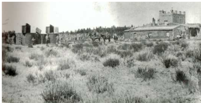
Figura 2. Vista Sudoeste del casco de la Chacra N°1 erigido sobre el ex-Fortín La Isla. A la izquierda de la foto están las cúpulas giratorias del heliómetro y el refractor. Entremedio se ven los albergues de los anteojos de pasos, miembros de la misión y personal de la chacra. Al fondo de la escena hay una arboleda a ambos lados del Arroyo Maldonado. (Foto gentileza Museo y Archivo Histórico Municipal de Bahía Blanca).
