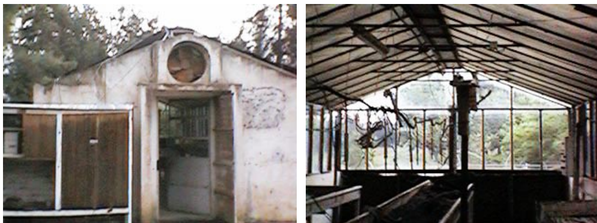
Figura 1.- Vista exterior e interior de la cámara de injertación
