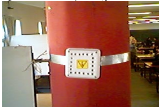
Figura 7: Detalle de la casilla de protección la cual contiene el adquirente de datos.
