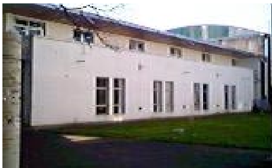
Figura 1: Vista exterior del aula en planta baja.
