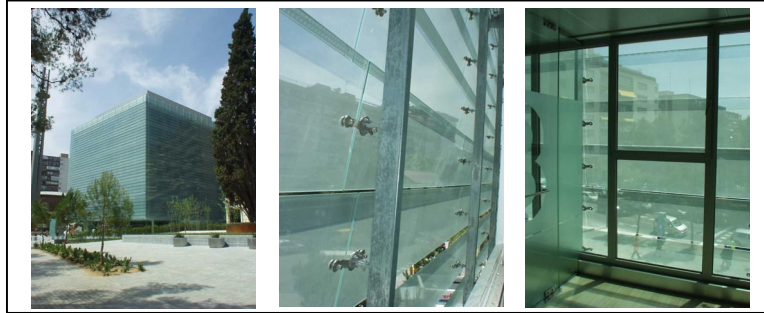
Figura 6: Imágenes caso 3: exterior , intermedio protección-fachada vidriada e interior
