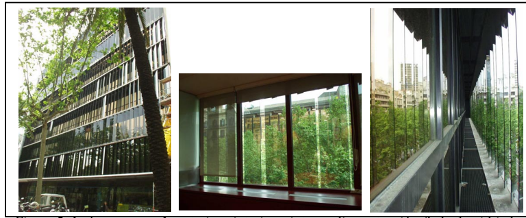
Figura 2: Imágenes caso 1: exterior , interior e intermedio protección-fachada vidriada
