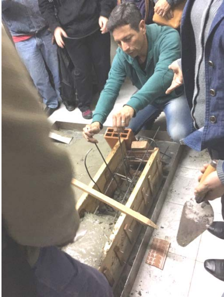
Clase de hormigonado de viga de fundación.
