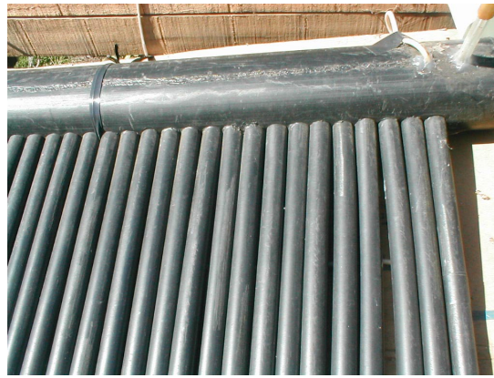
Figura 2 b) Foto que muestra el armado del colector.
