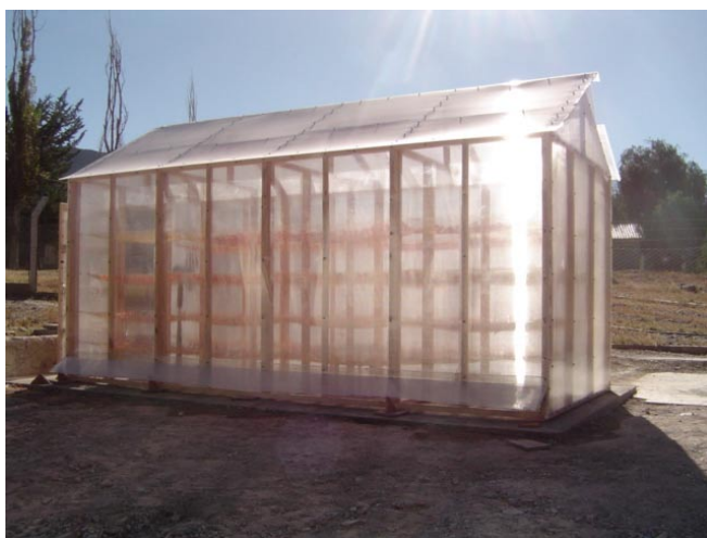
Figura 1: Secador-invernadero de policarbonato.
