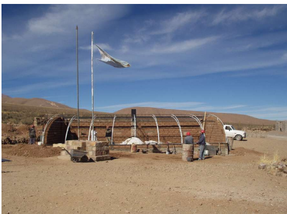
Figura 3: Etapa constructiva (norte).
