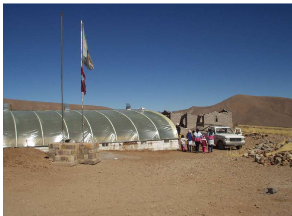
Figura 5: Vista exterior del invernadero.
