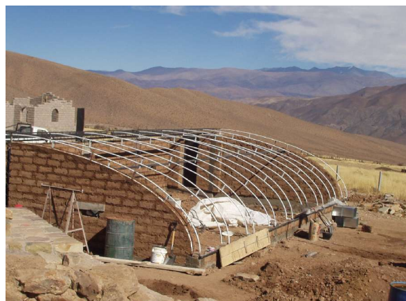
Figura 4: Etapa constructiva (noreste).
