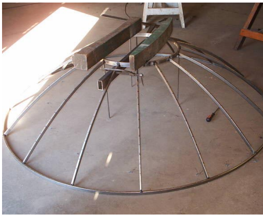
Fig. 2.- Muestra algunas de las etapas constructivas: la estructura soporte con su aro central, sus brazos y, el corte de los aros y la colocación fina de los aros de lámina de aluminio reflejante.
