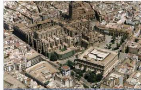
12 - Sevilla, Rehabilitación del CH 1994, Plan Especial de Protección del CH
