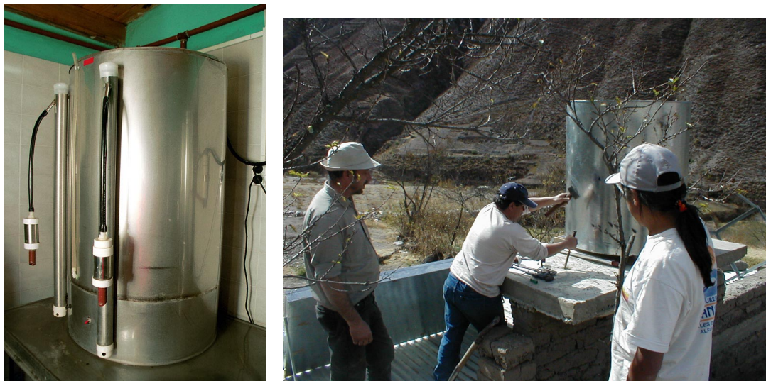
Figura 5: purificación de agua por radiación UV (a la izquierda) y filtrado y colectores y tanque de agua caliente (a la derecha).
