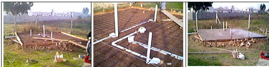
Figura 2: Imágenes del Módulo edilicio en construcción. Plancha de fundación e instalaciones de desagüe.
