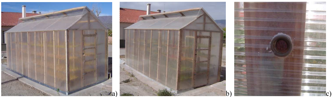
Figura 1: Secador solar de policarbonato y madera: mayo de 2004 (a) y mayo de 2005 (b). Oxidación de un clavo (c).
