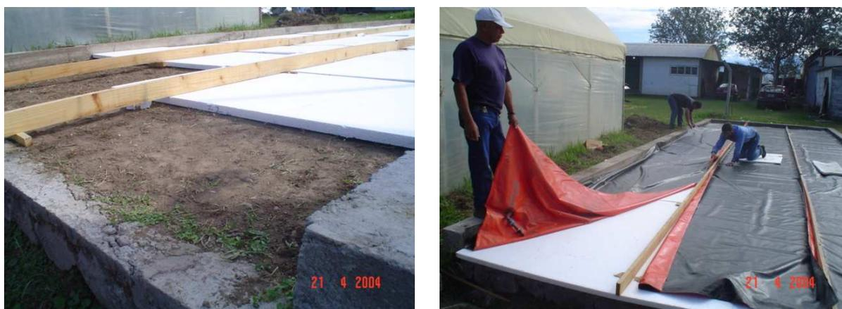
Figura 2: a) Fotos de la aislación inferior del colector y b) de la colocación de las bolsas de PVC
