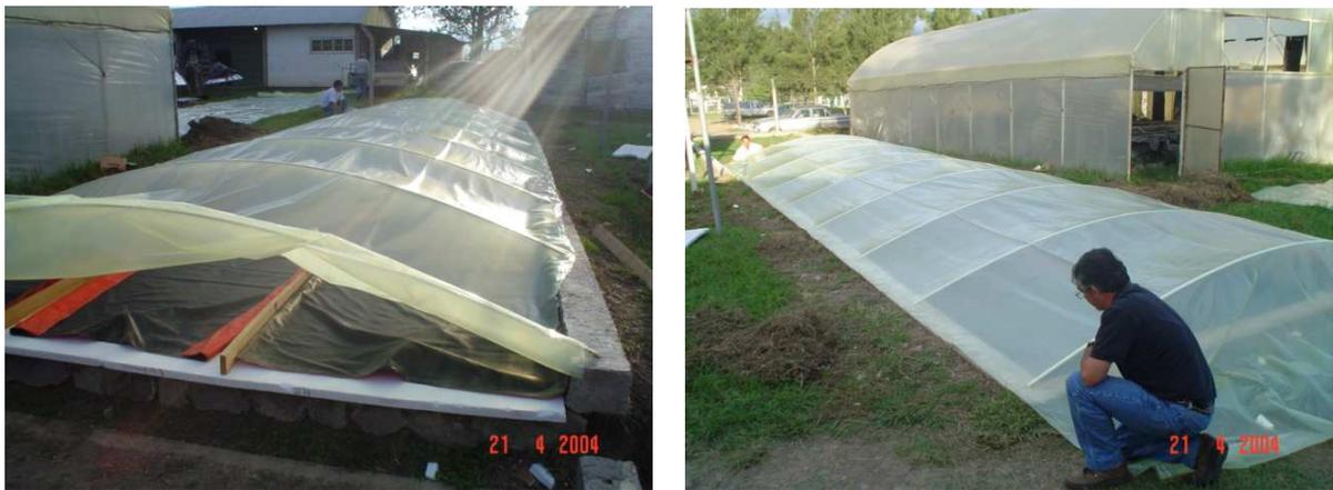
Figura 5: a) y b) Fotos de la colocación de la cubierta de plástico
