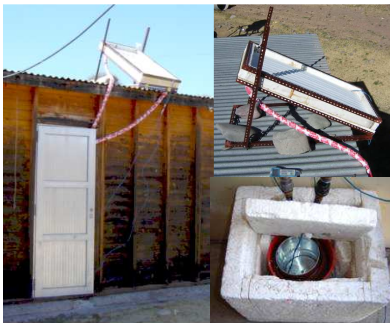
Figura 2. Vistas de la instalación del equipo y de la conservadora.
