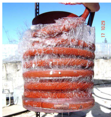
Figura 6. Hielo formado en el serpentín.
