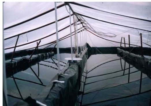
Figura 1 c) Fotografía interior de los estanques 3 y 4.
