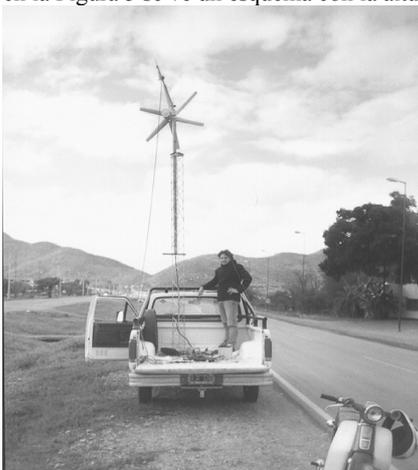
Figura 4: aerogenerador montado en la camioneta para realizar el ensayo.
