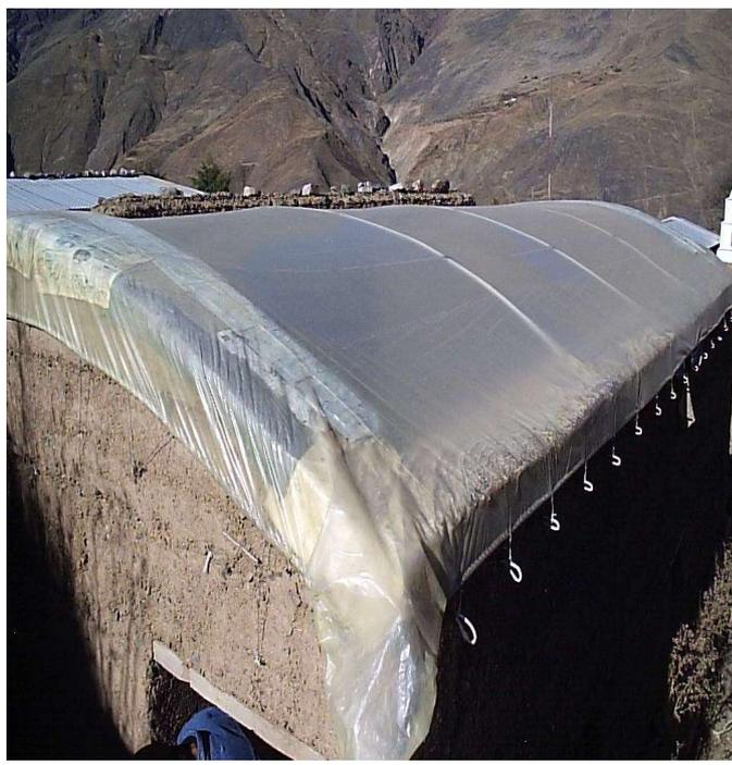
*Figura 6: Detalle de colocación de la cubierta*
