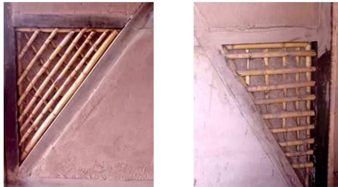
Figura 9: triángulos en esquina, sin el revoque final, para mostrar la disposición de las cañas dentro del panel.
