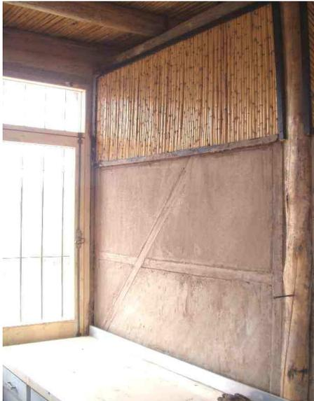
**Figura 6:** vista del muro terminado sin pintar, la caña superior es una terminación
