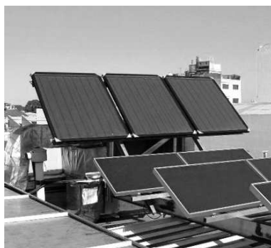
Fig. 2: Colectores colocados en obra
