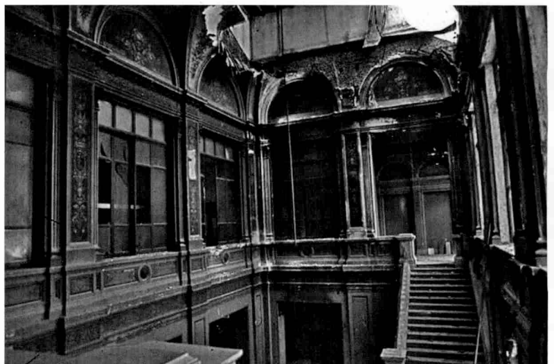
Figura 2. Escalera principal del Teatro Argentino, tras el incendio sufrido el 18 de octubre de 1977. Foto cortesía del Archivo fotográfico del Ministerio de Infraestructura.
