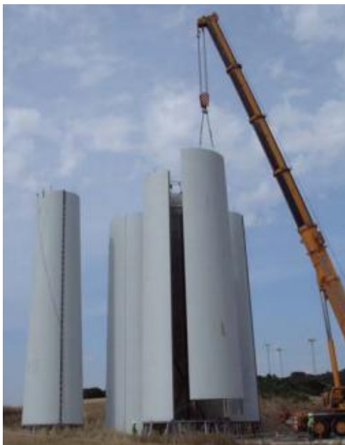
Fig. 4.7: Montaje de torres prefabricadas de hormigón (Torres de Hormigón para Aerogeneradores Multimegavatio, 2009)
