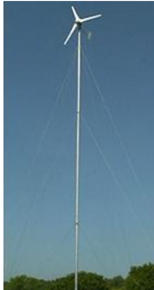
Fig. 4.5: Torre con riendas (Wind Turbine Towers)
