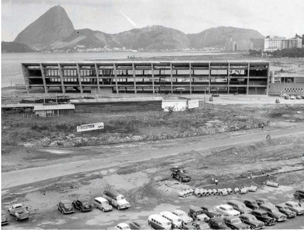
Figura 04. Vista de la estructura del bloque de exposiciones en construcción, c. 1960. Núcleo de Pesquisa e Documentação, FAU UFRJ.
