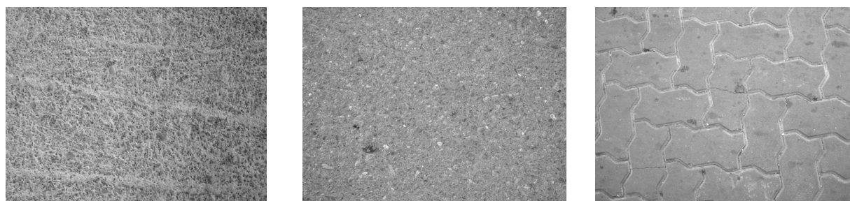
Pavimento de hormigón
